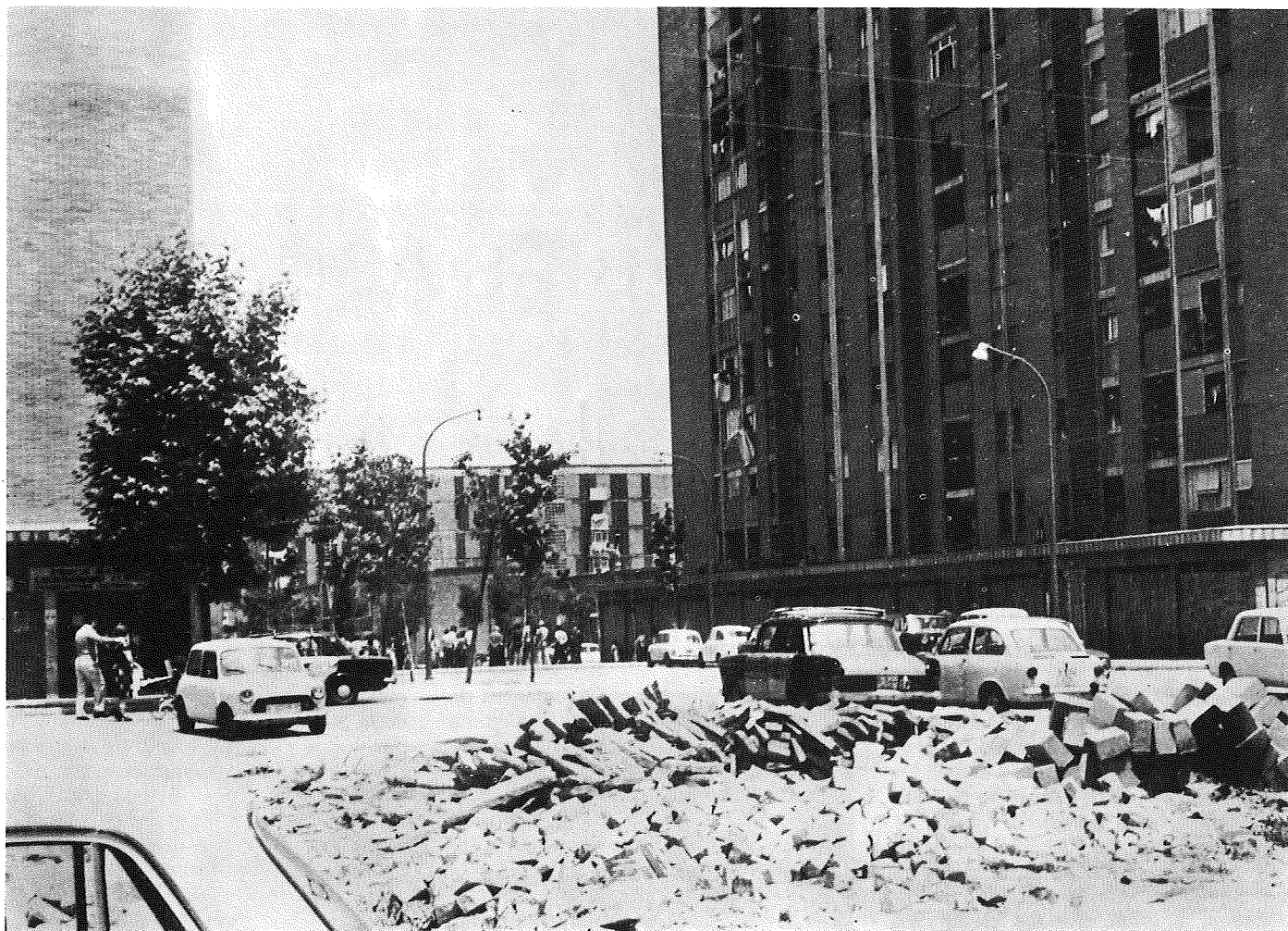
Algunos bloques edificados han tenido un envejecimiento prematuro a consecuencia de la humedad del subsuelo, los defectos de construcción y la utilización de materiales de desecho.
